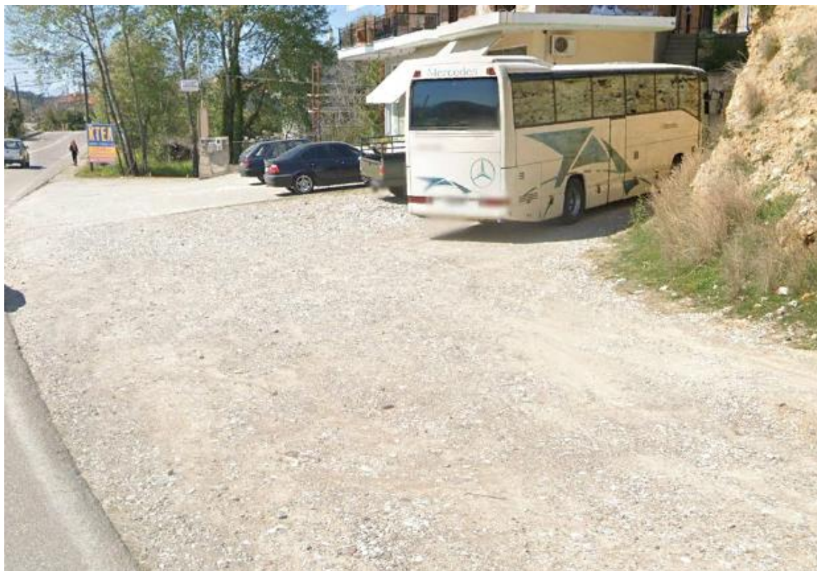
Εικόνα 19: Υφιστάμενη κατάσταση σταθμού ΚΤΕΛ
