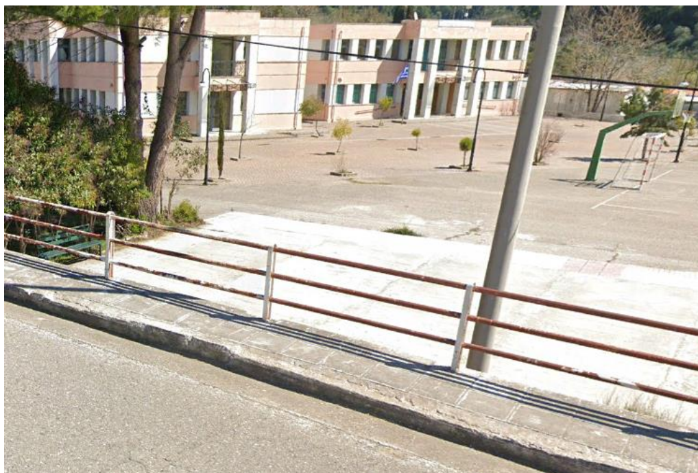
Εικόνα 16: Υφιστάμενη κατάσταση ΕΠΑ.Λ. Κρεστένων.
