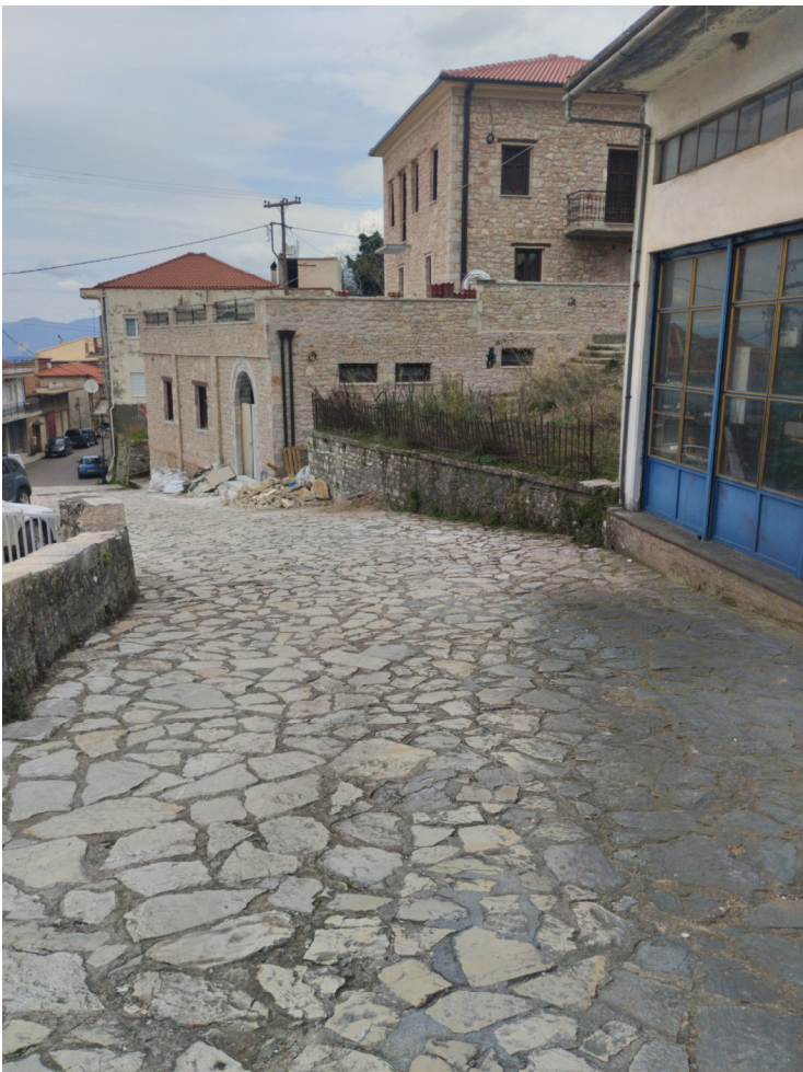
Εικόνα 2: Βορειοανατολική άποψη περιοχής μελέτης (τμήμα 1)
