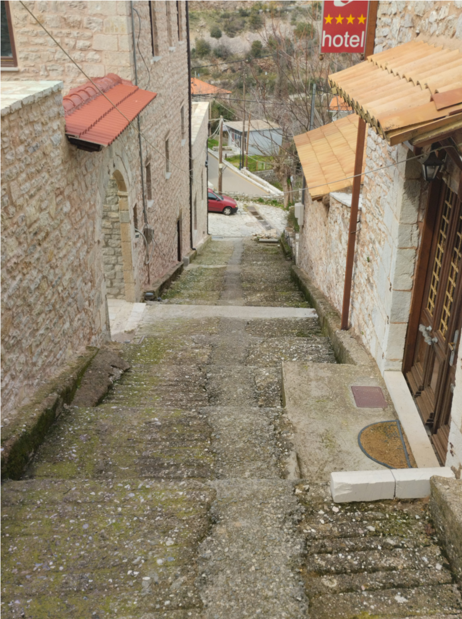
Εικόνα 5: Νοτιοανατολική άποψη σκάλας (τμήμα 1)
